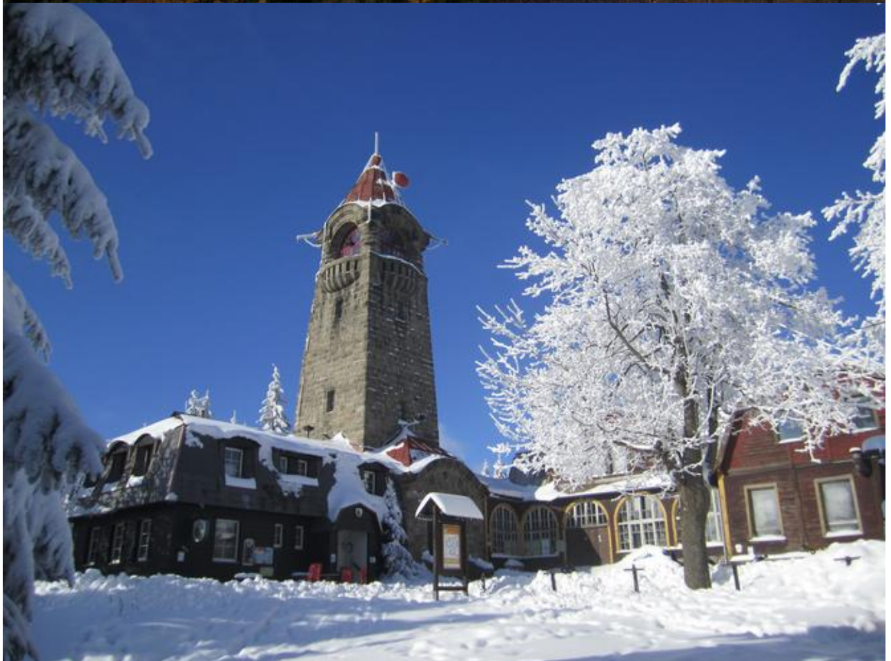
Rozhledna + restaurace Černá Studnice
