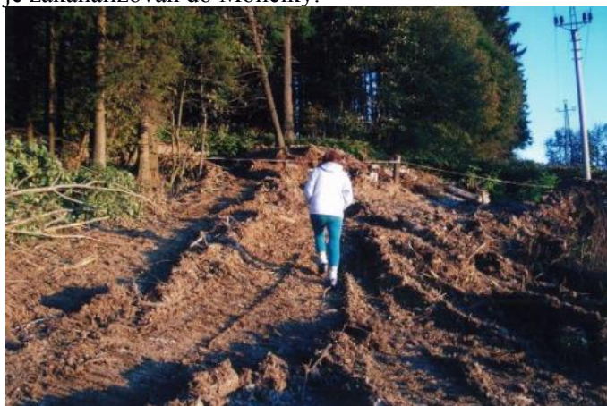
Bártův vrch – zlikvidovaný a zavezený vodojem
